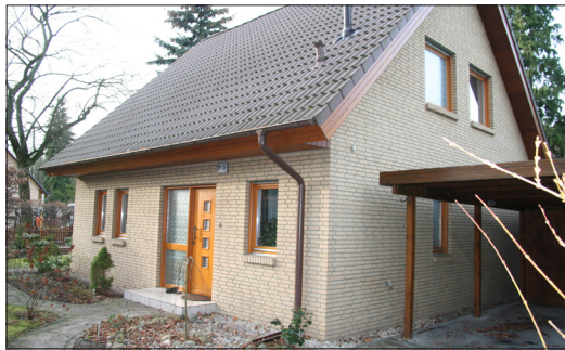
Haus mit Carport
